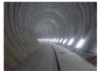
白子川地下調節池
