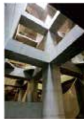
黒目川黒目橋調節池
