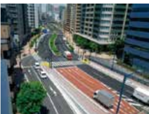
環状第6号線(山手通り) 大崎陸橋付近
