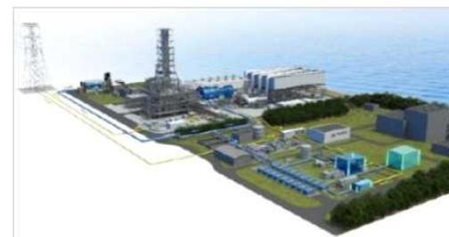
水素製造・貯蔵・発電実証設備イメージ図
